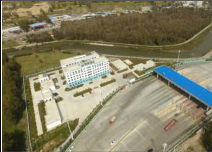
K46+750 桥梁预制场、拌合站 (利用永久征地范围)
