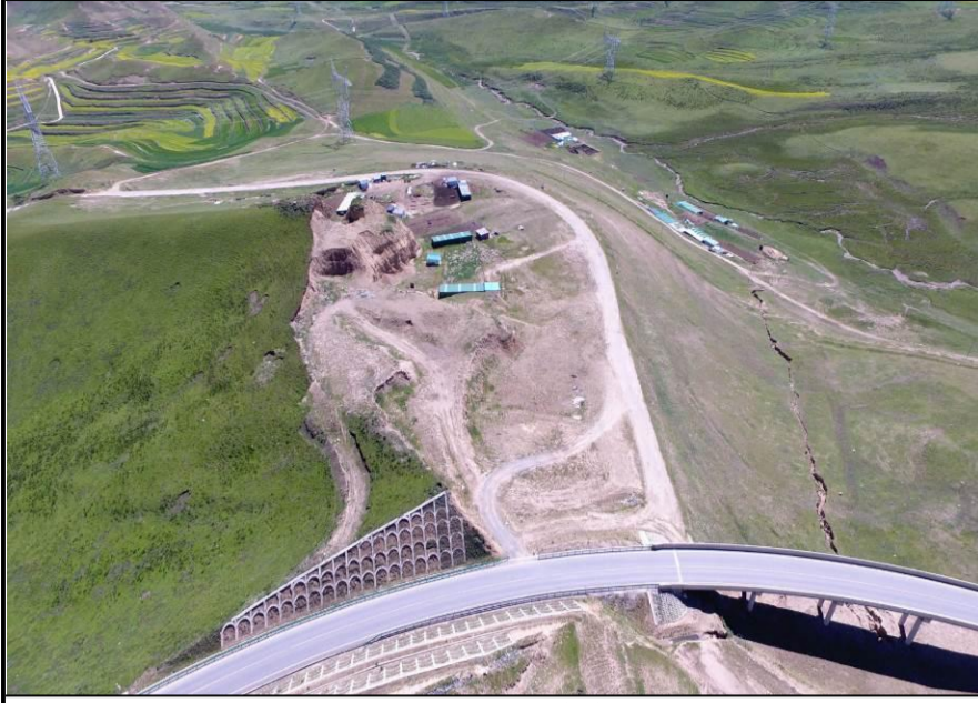
K81+000 日月山垭口大桥桥梁施工营地
