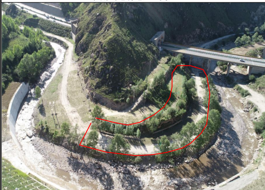
K57+630 施工驻地
