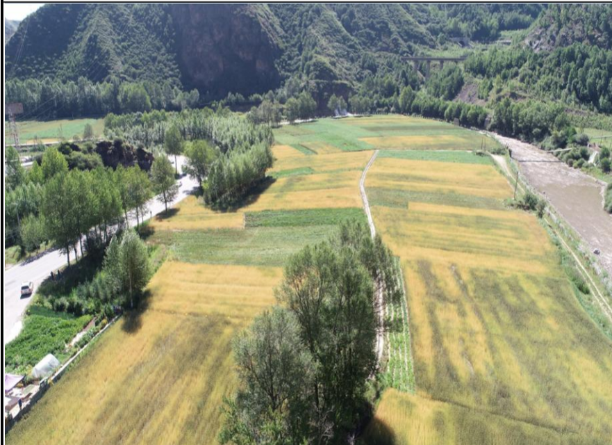
K36+560 桥梁预制场、拌合站
