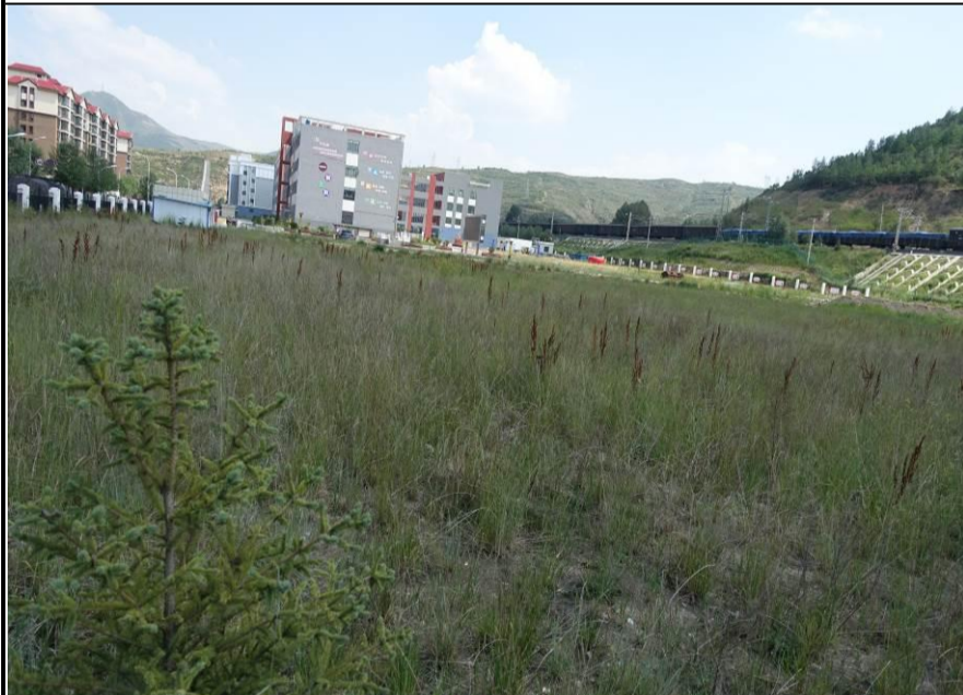
湟西公路 K1+500 沥青拌合站 (租用大华镇池汉村场地, 租用协议见附件 17)
