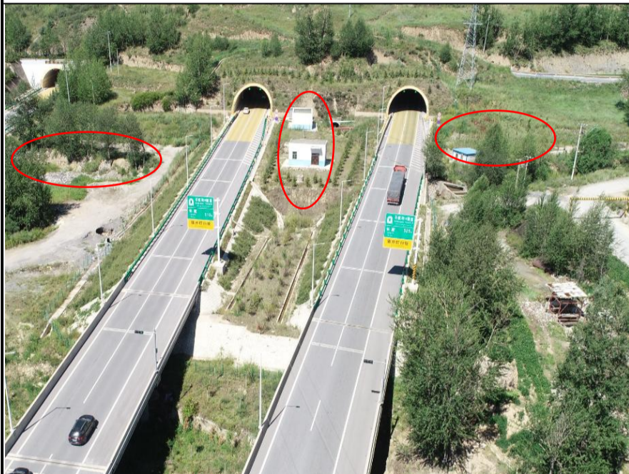
K34+640 石板沟一号隧道口施工人员驻地
