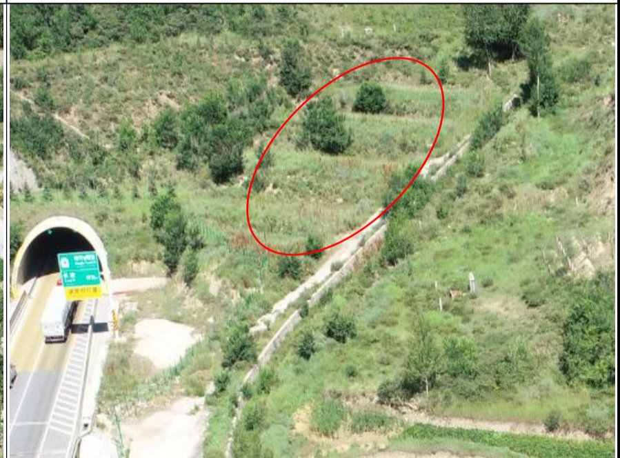
K36+500 响河一号隧道口施工人员驻地
