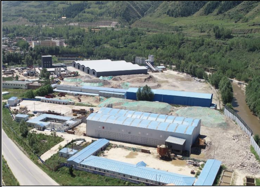
K32+500 路基 1 标项目部和拌合站和钢筋加工场 (租用当地场地, 已交还)
