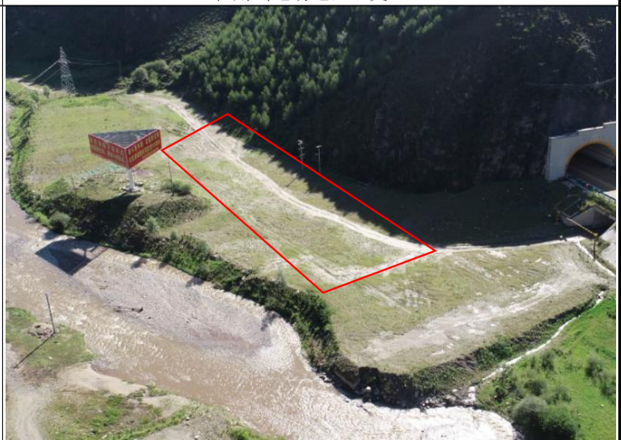
ZK59+770 施工驻地、拌合站
