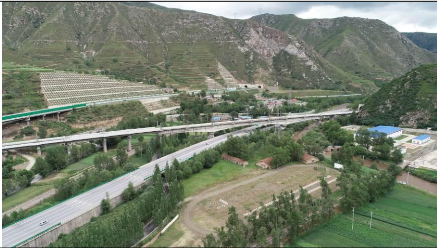
K40+500 灰条沟口村分离式，新建 4 车道段公路绿化及边防防护情况
